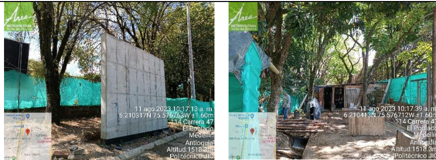
Fotos 1 y 2. Avance actual del proyecto
